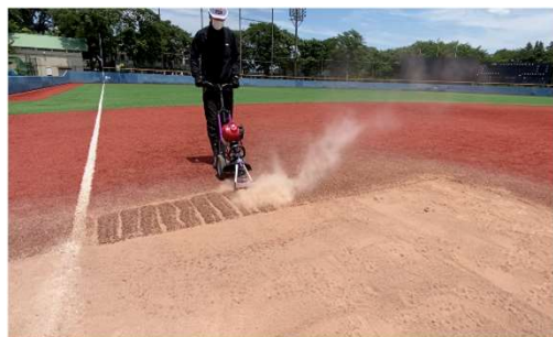
野球場の人工芝上にあるアンツーカの固着除去
