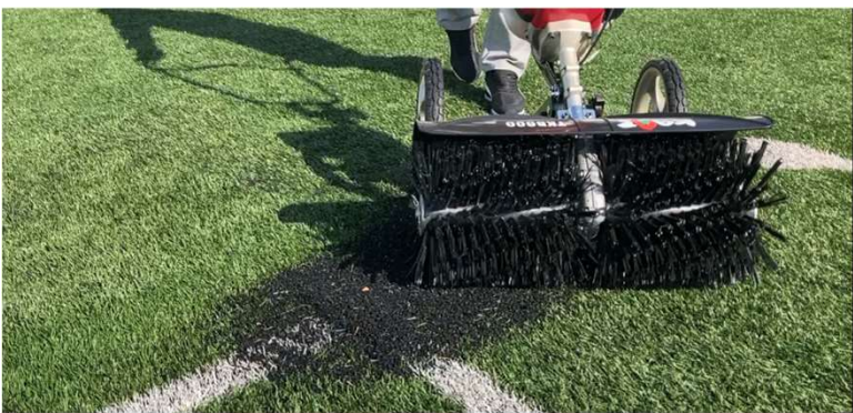
人工芝フィールドへの 充填材の撒り込み
